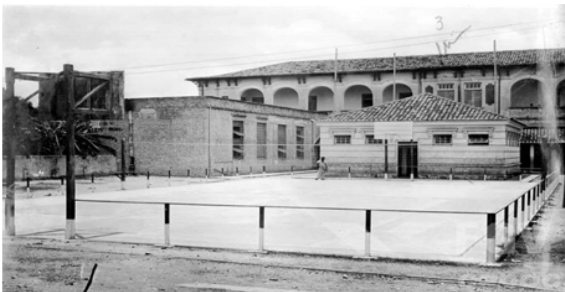
Figura 6 – Fundos do prédio do Liceu Industrial do RN (antes da reforma de 1937). Fonte: Acervo CEFET – RN (2006)
